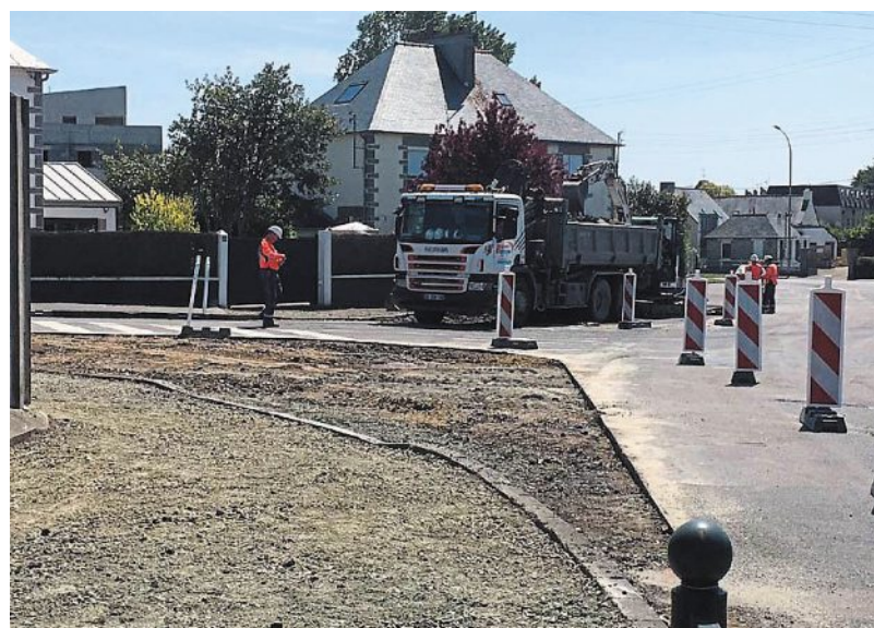
Les travaux d'aménagement des rues Saint-Alexandre et des Vergers ont débuté. Ils dureront plusieurs semaines.
